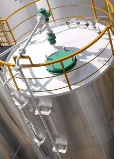
El arrestador de detonación debe convertirse en un punto que detenga el paso de flama cancelando la velocidad, la temperatura del gas en combustión y la presión que esta genera.
